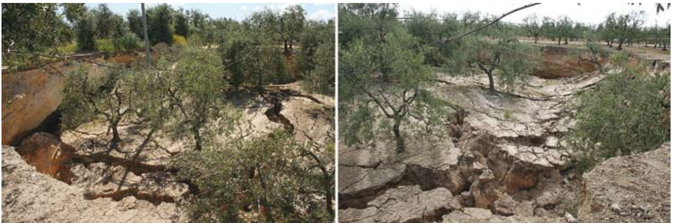
Fig. 1 - Vedute parziali del sinkhole.
